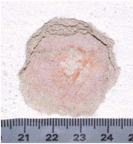
18–19. számú fényképek Becsapódási kráter vakolt (bal) és vaknyílás (jobb) téglafalon
