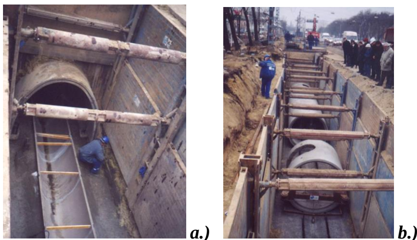
3.1 ábra: Szennyvíz főgyűjtő építése Budapest, Mázsza tér:
