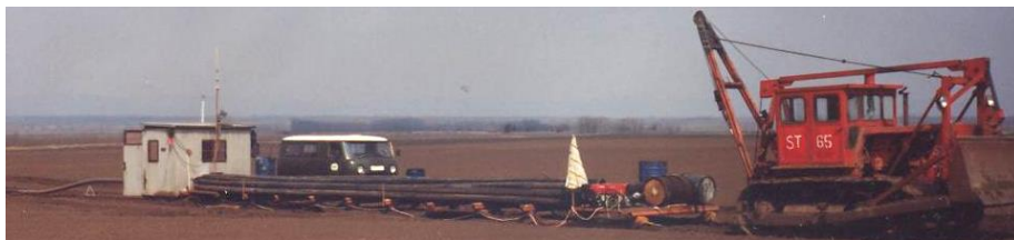
2.2.2.6 ábra: PE gázvezeték építés
