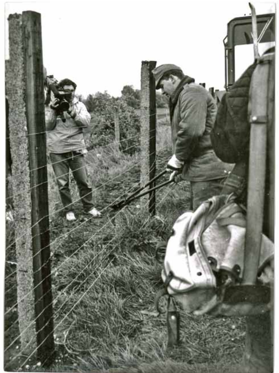
A nagy bontás: 1989. május 2. Die große Abrissaktion: 2. Mai 1989 The great dismantling: 2 May 1989
