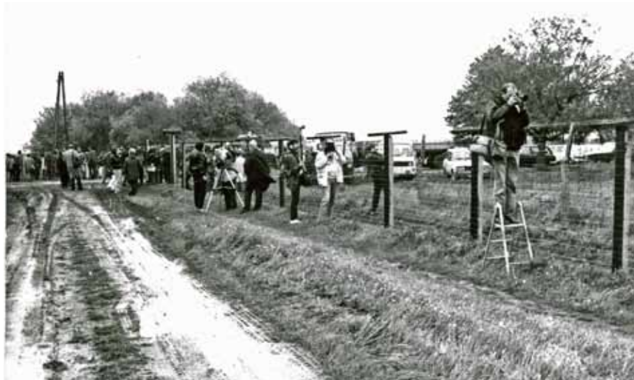
A nagy bontás: 1989. május 2. Die große Abrissaktion: 2. Mai 1989 The great dismantling: 2 May 1989
