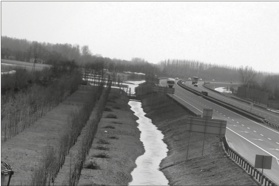
7. ábra: A térség belvízelvezetését akadályozó autópályát
